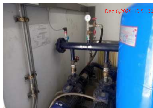
ภาพที่ 2.2-7 ระบบสูบน้ำประปาและวาล์วควบคุมการจ่ายน้ำ
