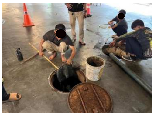
ภาพที่ 2.2-23 การสูบบ่อเกรอะ
