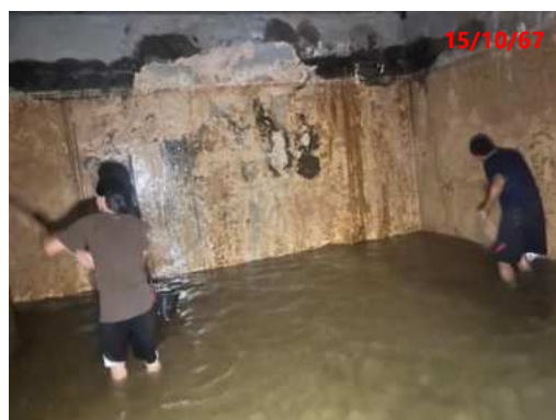
ภาพที่ 2.2-22 การทำความสะอาดถังเก็บน้ำสำรอง
